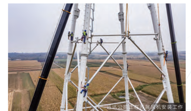
运达公司正在开展风机安装工作
